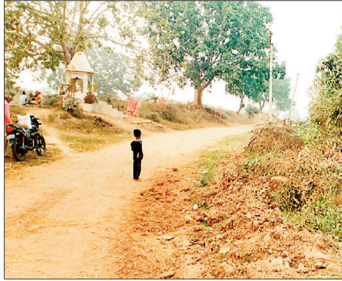
तहसील ऑफिस तक पहुंचने वाली जर्जर सड़क।
